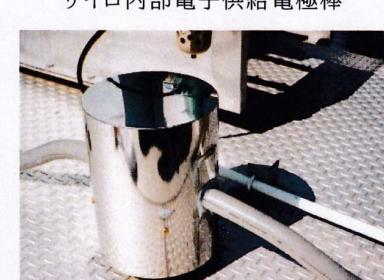
電極部雨よけカバー取り付け状況
