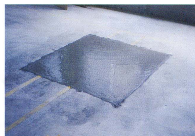
コンクリート補修
