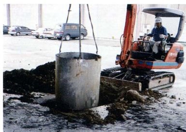
このあと金枠を抜き取って残土で埋め戻す。
