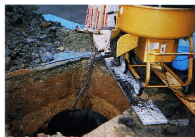
型枠の中に水で練った炭素（純度の高い MEC-9号）を施設する。
