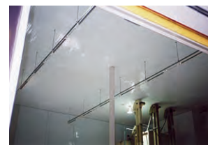
MDAシャワー空気浄化装置 工場内の空気清浄化・防虫・ 静電気の抑制
