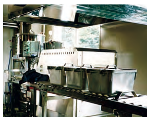
AIHO連続自動炊飯ライン 10釜連続炊飯テストラインの 設備据え付け状況
