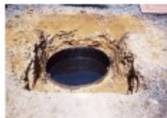
炭素埋設 工場敷地、工場内の電磁場修正
