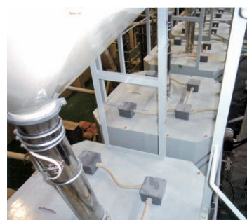
酒米タンク電極棒取り付け状況
