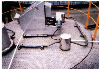
サイロタンク上部 MDA 電子供給設置状況
