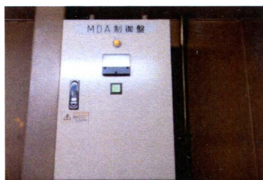
MDA 電子発生制御盤
