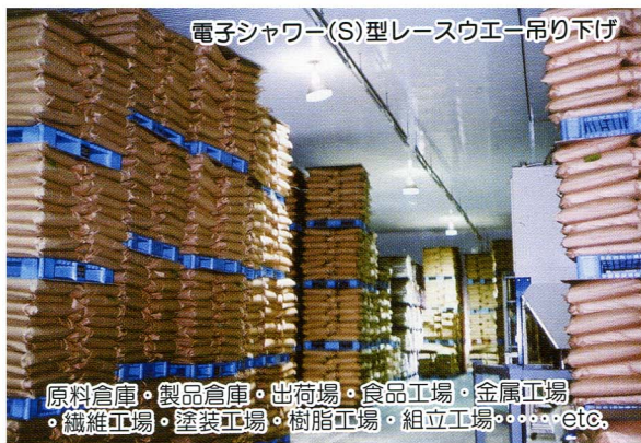
倉庫内MDA電子シャワー空気浄化装置設置状況
