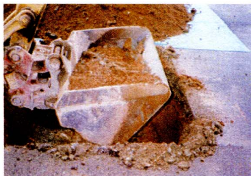
精米工場敷地の要所に炭素埋設用の穴を掘削する。
