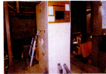
MDA色彩選別機除電装置取り付け 状況 (うるち米用)
