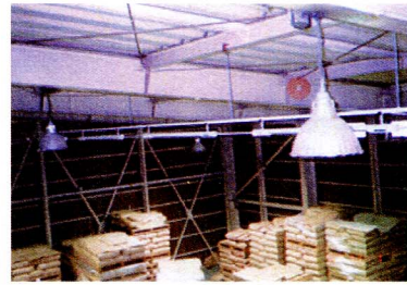
MDA電子シャワー空気浄化装置 (製品置き場、出荷場)
