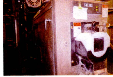
MDA精米機除電装置取り付け状況 サタケミルモア25馬力精米機
