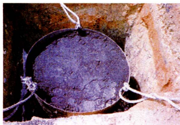
規定量の炭素を金枠の中に入れ終えたら金枠の外側に残土を入れて固める。
