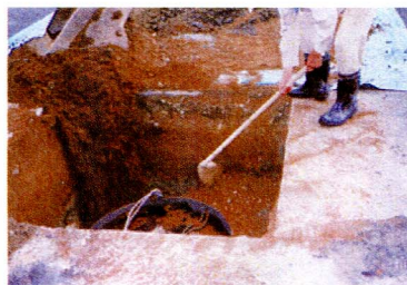
このあと残土で埋め戻し金枠を抜き取って完了。
