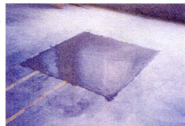
コンクリート補修
