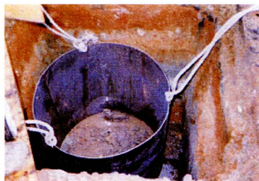
掘削した穴の中に炭素埋設用の型枠をセットする。
