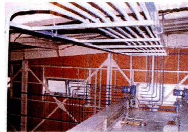
MDA電子導電線送り配管状況
