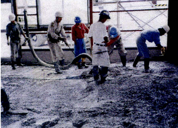
炭素入生コン打設状況
