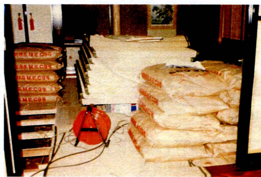
和室の床を一部を開放して床下全面に施工
