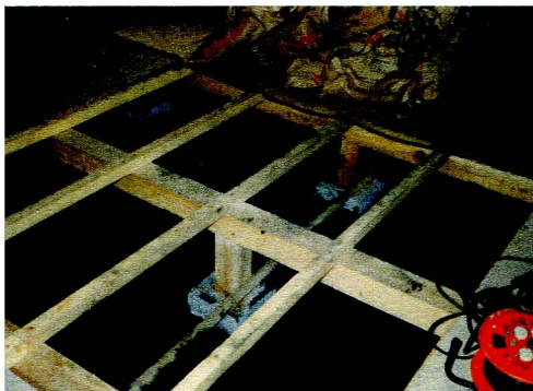
床下のMEC炭素敷きならし状況
