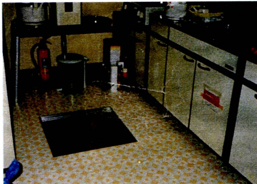
台所床下収納庫より、床下全面を施工する
