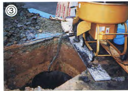
③ 型枠の中に水で練った炭素（純度の高いMEC-9号）を施設する。
