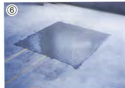
⑥ コンクリート補修
