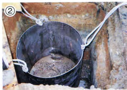
② 掘削した穴の中に炭素埋設用の型枠をセットする。
