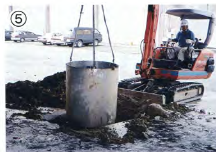
⑤ このあと金枠を抜き取って残土で埋め戻す。
