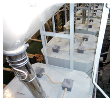
玄米タンク電極棒取り付け状況
