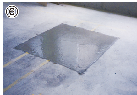
⑥ コンクリート補修
