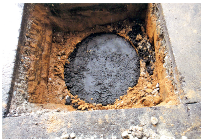
炭素埋設工事（床）
