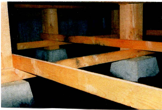
MEC-9号炭素：床下敷きならし後の状況
