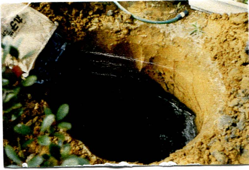
住宅の庭先に施工した炭素埋設
