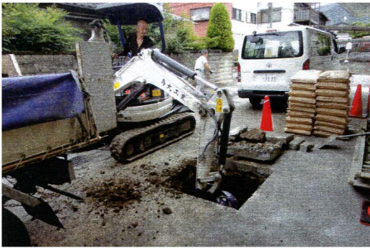
敷地の要所に炭素埋設工事を施工
