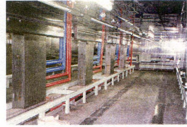
炭素入り土間コンクリート完了。
