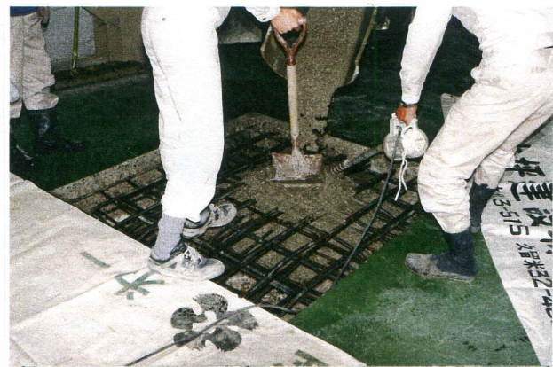
炭素埋設完了後補修工事施工状況
