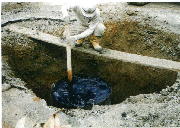
工場敷地に炭素埋設施工状況
