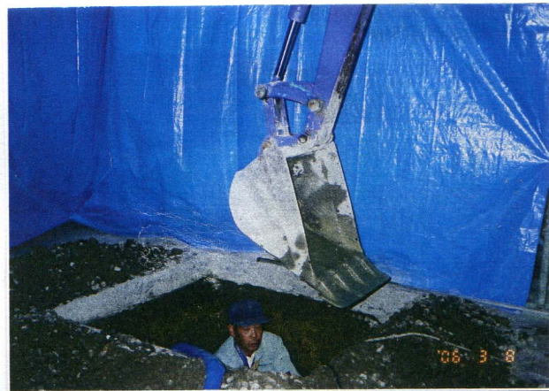
工場内要所に炭素埋設・掘削工事状況
