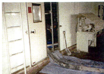
ファイナルプルファー室入り口工事 状況。
