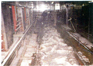
土間の改修工事。既設の土間を撤去。
