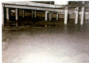
ファイナルプルファー機械下の炭素 入り土間の施設状況。
