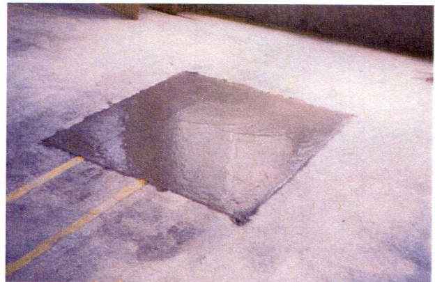
コンクリート補修して完了
