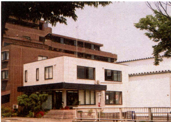
株式会社 米屋本社屋 右は工場棟
