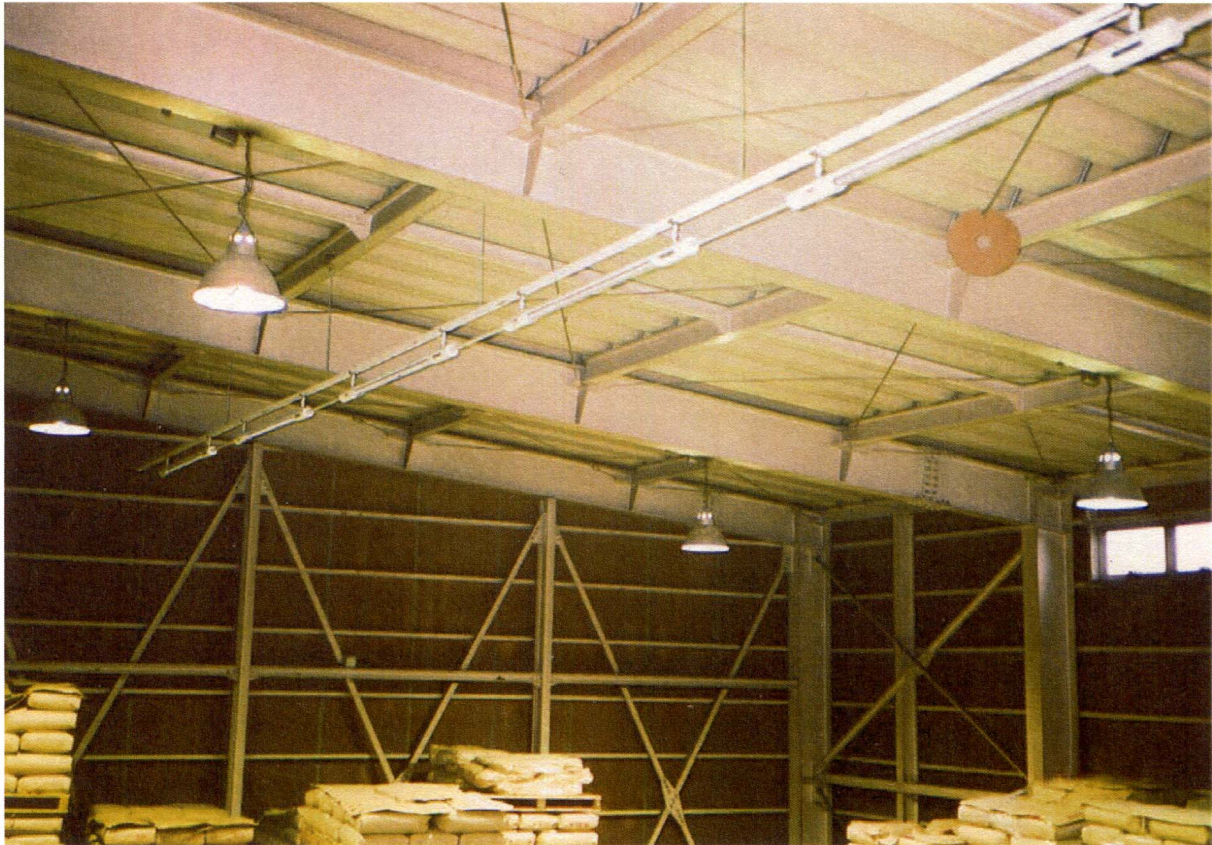
出荷場MDA電子シャワー取付状況
