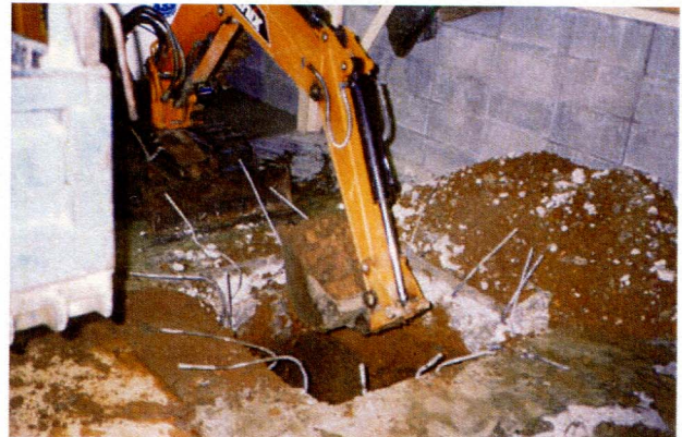
精米工場敷地の要所に炭素埋設用の穴を掘削する。
