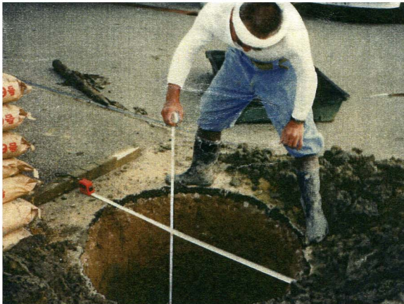
電磁場修正 炭素埋設工事
