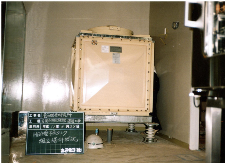
MDAマイナスイオン帯電水自動製造給水型 タンク 1000×1000×1000 1 t 型据付状況
