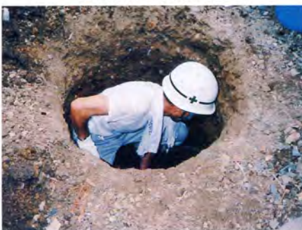
住宅敷地に炭素埋設
