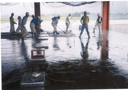
新設 低温倉庫炭素入り土間工事
