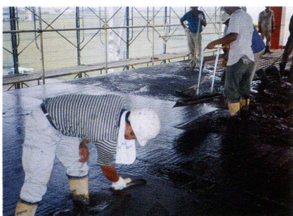
炭素入モルタル施工状況
