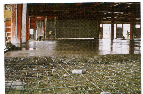
新設 食品工場炭素入り土間工事
