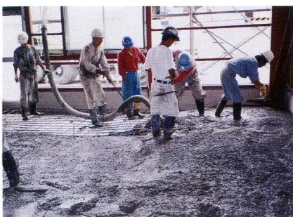
炭素入生コン打設状況
