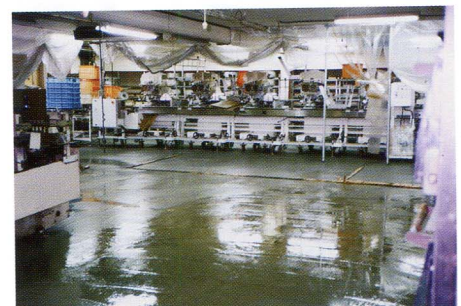
既設 食品工場炭素モルタル土間改修工事
