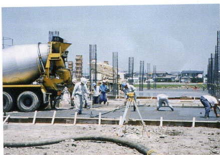
新設 大型工場・店舗炭素入り土間工事
