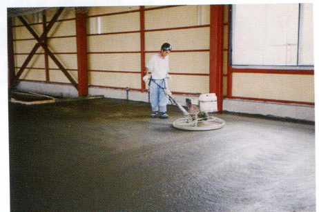
新設 倉庫炭素入り土間工事
