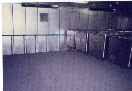
既設 発酵室炭素入り土間改修工事
