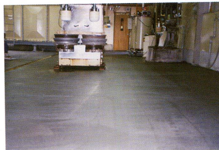
既設 食品工場炭素モルタル土間改修工事
