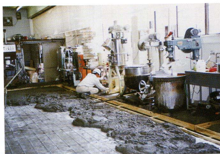
既設 食品工場炭素入り土間工事
