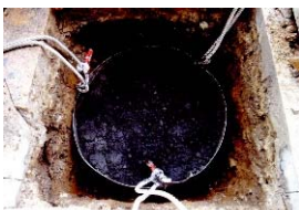
炭素埋設工事
