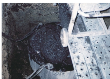
規定量の炭素を金枠の中に入れ終わったら金枠の外側に残土を入れて固めて金枠を抜き取る。
