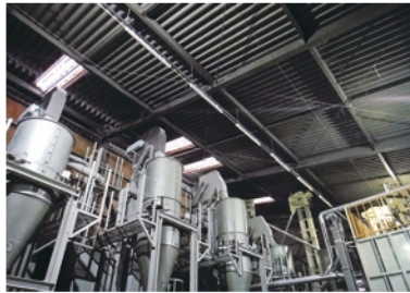
酒米工場の天井に電子シャワー空気浄化装置MX-9型を設置する
