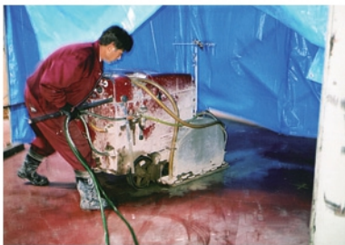
コンクリート土間のカッター切りとハツリ工事
