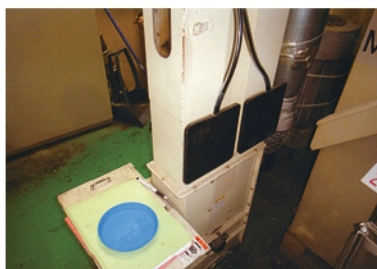
昇降機に静電気除電電極板を設備
