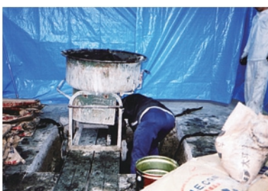
モルタルミキサーに炭素を入れ水を加えて練る。
