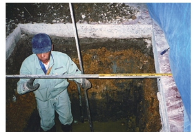
炭素埋設用の規定寸法の穴を掘削する。
