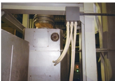
酒米機にMDA電子を供給配管状況
