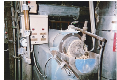
MDA静電気除電装置取り付け状況 (エンゲル)
