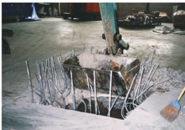
コンクリート土間の解放と掘削。 (工場生産ラインの床)
