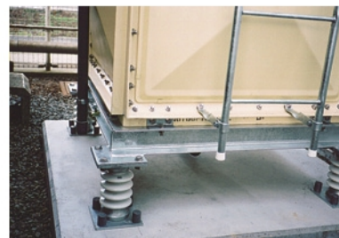
電子水タンク据付状況
