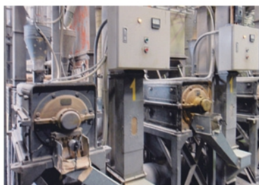
MDA静電気除電装置取り付け状況 (精麦機内部)
