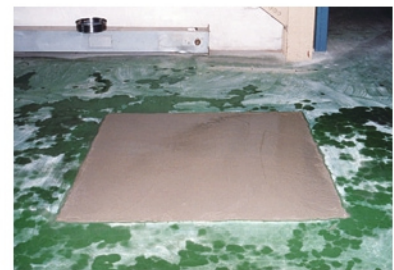
このあとコンクリート補修して完了。
