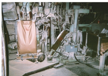
MDA静電気除電装置取り付け状況 (包装機)
