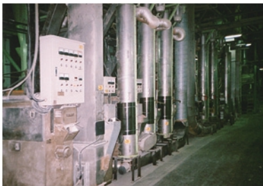
MDA静電気除電装置取り付け状況 (昇穀機)
