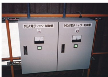
MDA電子シャワー空気浄化制御盤
