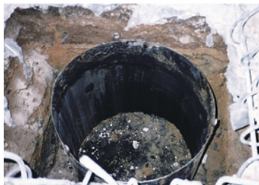
掘った穴の中に金枠をセットする。
