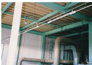
MDA電子シャワー空気浄化装置 (包装ライン)
