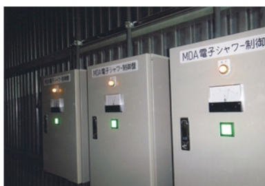
MDA電子シャワー空気浄化制御盤
