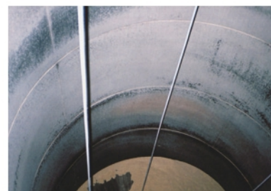
原料タンク内部のMDA電極棒設置 状況。
