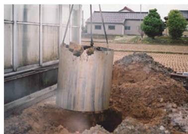
金枠の抜き取り。
