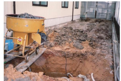
モルタルミキサーに炭素を入れ水を加えて練る。
