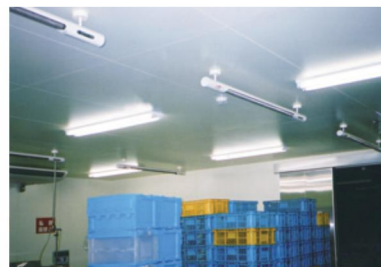
MDA電子シャワー空気浄化装置 (製品保管庫) MX-9(S)型
