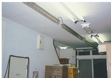
MDA電子シャワー空気浄化装置 (製造ライン) MX-9(P)型
