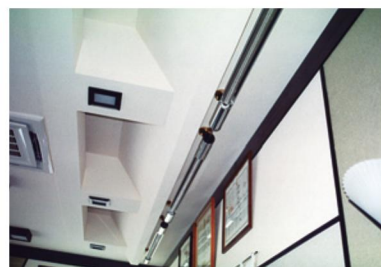
MDA電子シャワー空気浄化装置 (店内) MX-9(S)型
