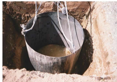
掘った穴の中に金枠をセットする。
