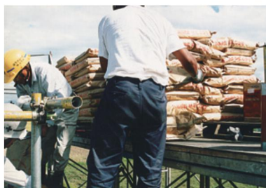
ヤグラの上から生コン車のホッパーに炭素を入れる。
