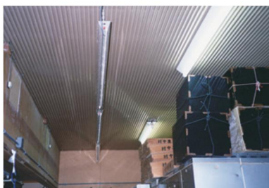
MDA電子シャワー空気浄化装置 (製品保管庫) MX-9(P)型
