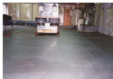
炭素入り土間施設完了。水が引いたら均し仕上げをする。
