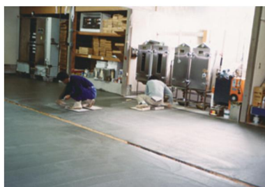
炭素入り生コンの施設状況。
