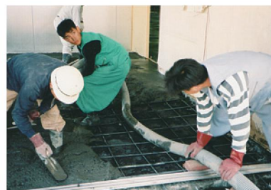
炭素入り生コンの施設状況。
