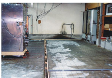
補強のため鉄筋メッシュを敷く。
