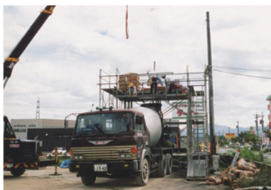
ヤグラを組んで、生コン車に炭素を混入する。
