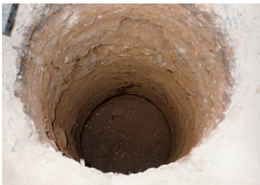
工場敷地の要所に炭素埋設用の穴を掘削する。
