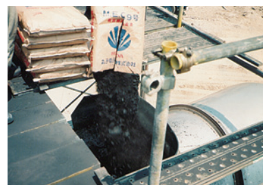
ヤグラの上から生コン車のホッパーに炭素を投入する。
