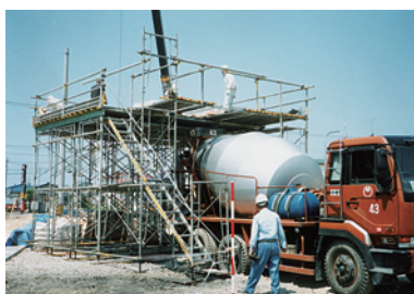
生コン車に炭素を投入するヤグラを組み立てる。
