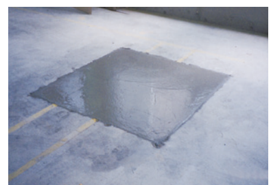
コンクリート補修
