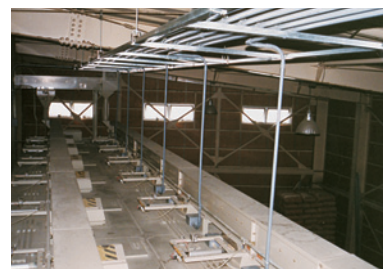
玄米タンク上部MDA電子電極取り付け状況
