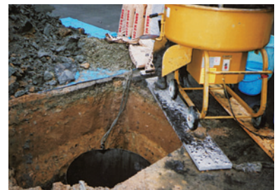
型枠の中に水で練った炭素（純度の高いMEC-9号）炭素を施設する。
