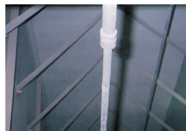
玄米タンク内部MDA電子供給電極 棒取り付け状況
