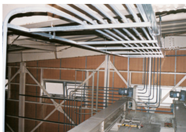
MDA電子導電線送り配管状況
