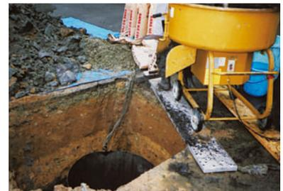
型枠の中に水で練った炭素（純度の高いMEC-9号）を施設する。
