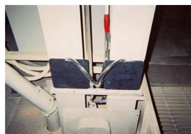
MDA除電電極板取り付け状況
