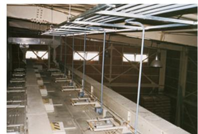
玄米タンク上部MDA電子電極取り
