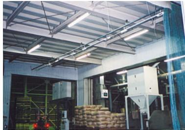
MDA電子シャワー空気浄化装置
