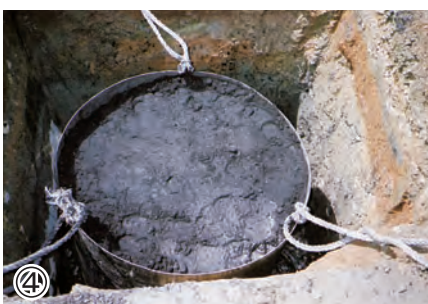
④ 規定量の炭素を金枠の中に入れ終わったら金枠の外側に残土を入れて固める。
