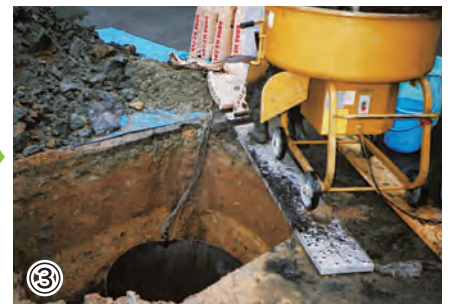
③ 型枠の中に水で練った炭素（純度の高いMEC-9号）を施設する。
