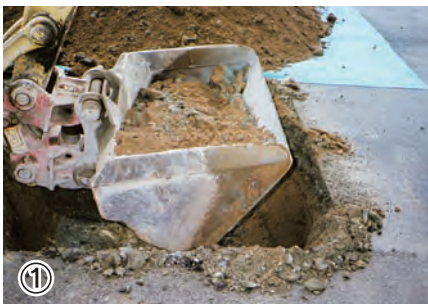
① 工場敷地の要所に炭素埋設用の穴を掘削する。
